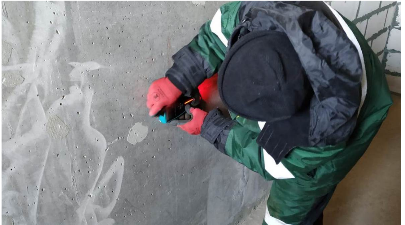
Рис. 4.4.1.Определение параметров армирования в монолитном железобетонном пилоне магнитным методом прибором Proceq Profoscope
