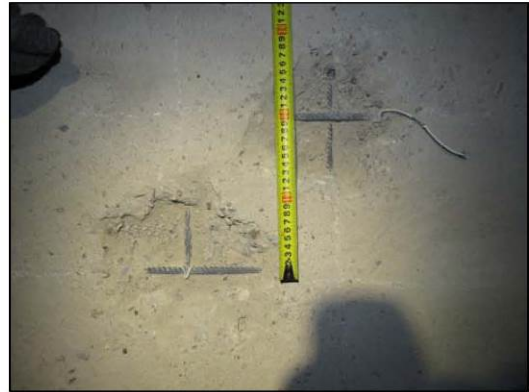
ФОТО 22. Уточнение шага рабочей арматуры напольной поверхности железобетонной плиты перекрытия 2-го этажа между осями «Г/4»-«Д/4» и «2/4»-«3/4».
