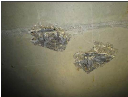
ФОТО 31. Общий вид вскрытия потолочной поверхности монолитной железобетонной плиты перекрытия 3-го этажа расположенной по оси «Б/4» между осями «6/4» и 7/4.
