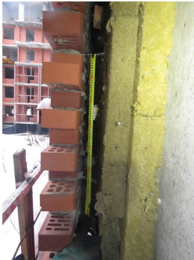
Рис. 3.4.4. Замер шага гибких связей по высоте наружной стены жилого дома (тип 2)
