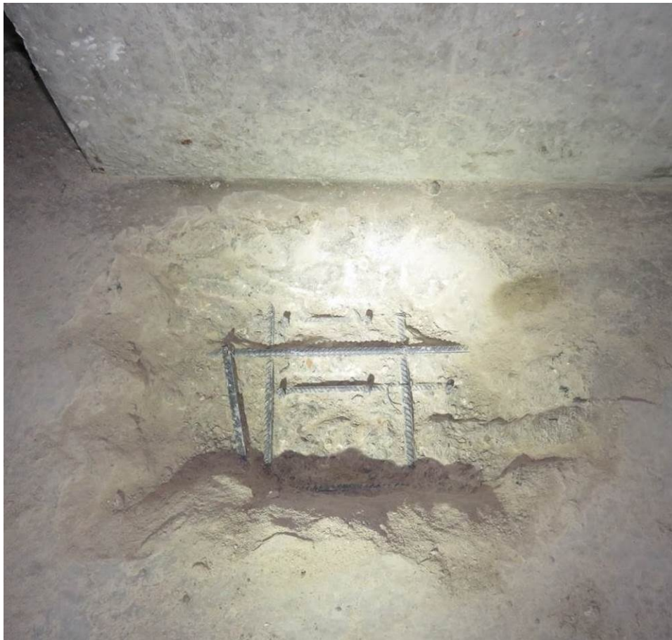
Рис. 3.1.3. Общий вид вскрытия фундаментной плиты секции 4 по оси 6/4 между осями Б/4-В/4
