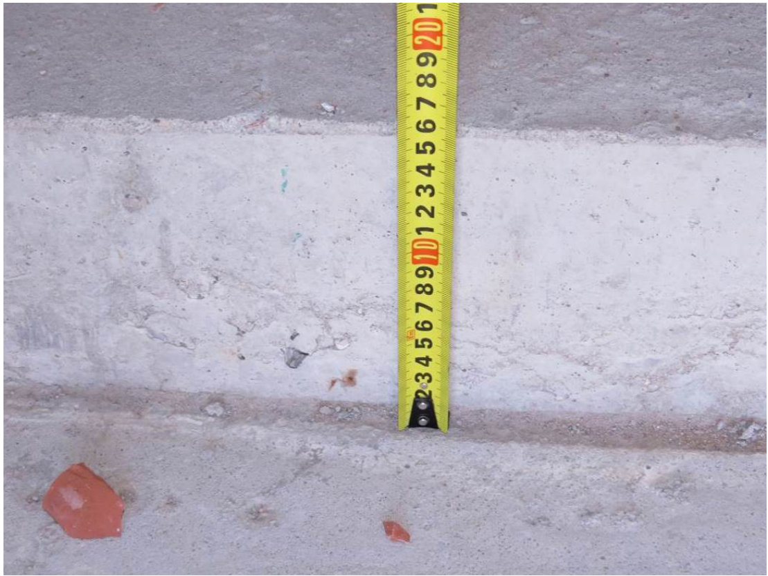
Рис. 3.5.5. Уточнение высоты подступенка монолитной лестничной одномаршевой конструкции
