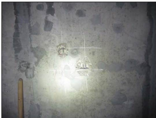
ФОТО 3. Общий вид вскрытия монолитной железобетонной стены расположенной на пересечении осей «1/4» и «Г/4».
