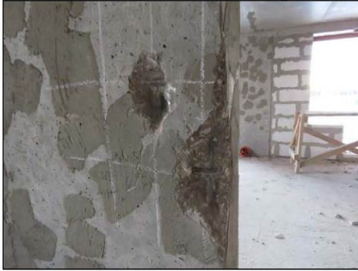
ФОТО 25. Общий вид вскрытия монолитного ж/б пилона 3-го этажа на пересечении осей «Б/4» и «3/4».
