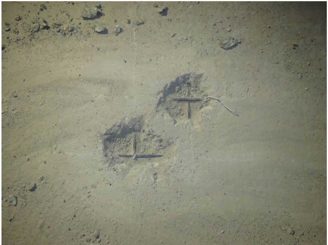
Рис. 3.3.7. Общий вид участка вскрытия монолитной ж.б. плиты перекрытия 2-го этажа между осями Г/4-Д/4 и 2/4-3/4 (зона верхнего армирования)
