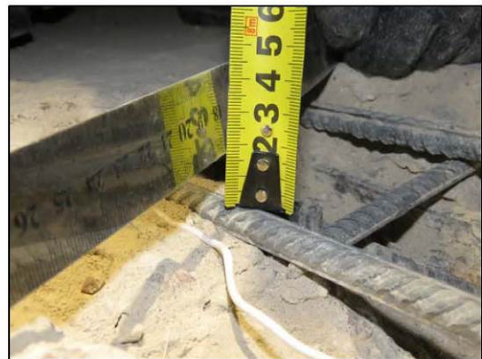
ФОТО 28. Уточнение защитного слоя бетона напольной поверхности монолитной железобетонной плиты перекрытия 2-го этажа расположенной по оси «А/4» между осями «3/4» и «4/4».
