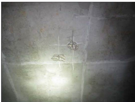
ФОТО 1. Общий вид вскрытия потолочной поверхности железобетонной плиты перекрытия подвала по оси «И/4» между осями «2/4» и «3/4».
