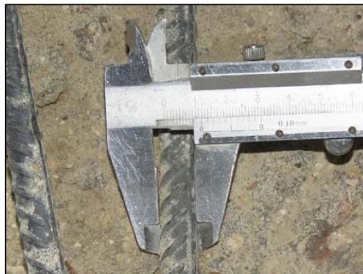
ФОТО 8. Уточнение диаметра рабочей арматуры монолитной железобетонной фундаментной плиты расположенной между осями «5/4»-«6/4» и «Б/4»-«В/4».
