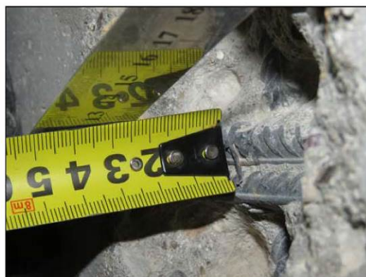
ФОТО 16. Уточнение защитного слоя бетона монолитного ж/б пилона расположенного на пересечении осей «Ж/3» и «8/3».
