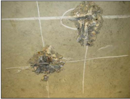
ФОТО 17. Общий вид вскрытия потолочной поверхности железобетонной плиты перекрытия 1-го этажа на пересечении осей «7/3» и «И/3».
