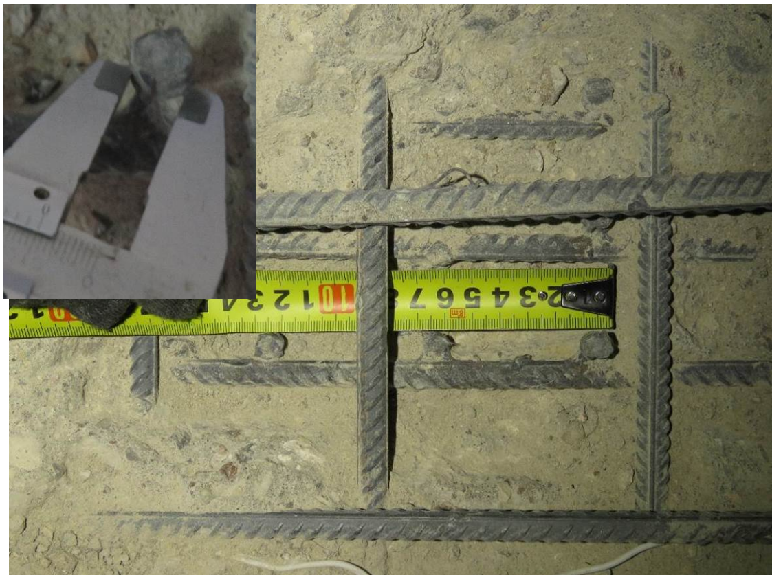
Рис. 3.3.10. Замер геометрических параметров поперечного армирования плиты перекрытия 2-го этажа в зоне пилона на пересечении осей А/4 и 4/4
