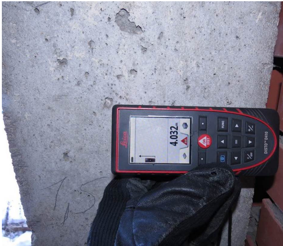
Рис. 2.3. Замер шага колонн секции №1 в уровне 1-го этажа по оси 11/1 между осями А/1-В/1 при помощи лазерного дальномера Leica DISTO D410
