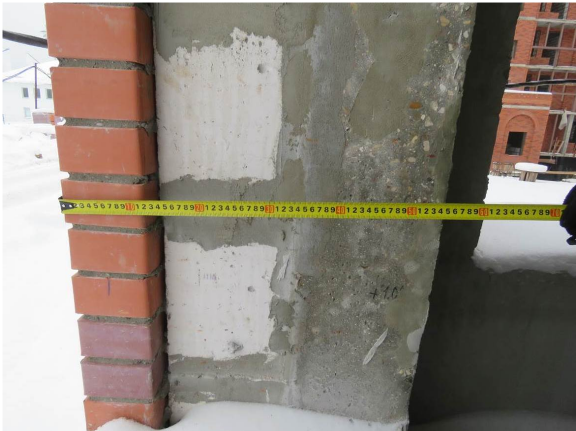
Рис. 3.4.2. Замер толщины наружной стены жилого дома в уровне 1-го этажа (тип 2)
