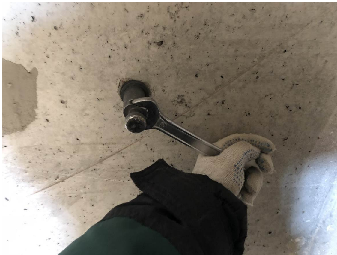
Рис. 4.2.3. Установка анкерного устройства и тяги в отверстии монолитной железобетонной стены
