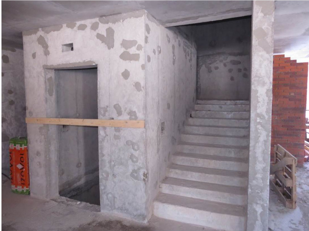
Рис. 3.5.1. Общий вид лестничной монолитной конструкции расположенной между осями 2/2-4/2 и Д/1-В/1, с обеспечением сообщения между первым и вышележащими этажами
