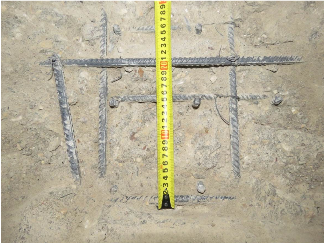
Рис. 3.1.5. Замер шага вдоль буквенных осей верхней зоны армирования фундаментной плиты на участке вскрытия по оси б/4 между осями Б/4-В/4 секция 4
