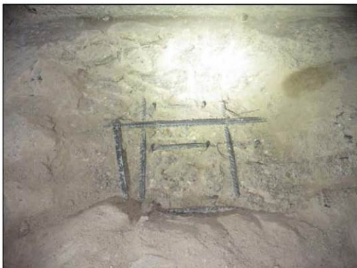
ФОТО 7. Общий вид вскрытия поверхности пола монолитной железобетонной фундаментной плиты расположенной между осями «5/4»-«6/4» и «Б/4»-«В/4».
