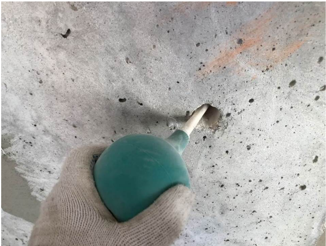
Рис. 4.2.2 . Продувка отверстия от пыли в монолитной железобетонной стене
