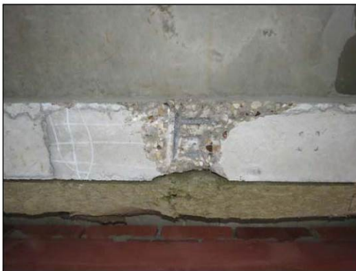
ФОТО 23. Общий вид вскрытия монолитной железобетонной балки расположенной по оси «2/4» между осями «Б/4» и «В/4».
