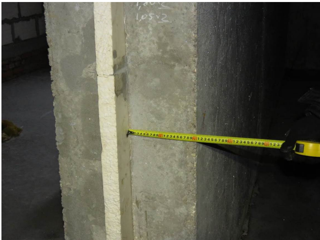
Рис. 2.1. Замер толщины внутренней монолитной ж.б. стены подвального этажа в зоне деформационного шва при помощи металлической рулетки
