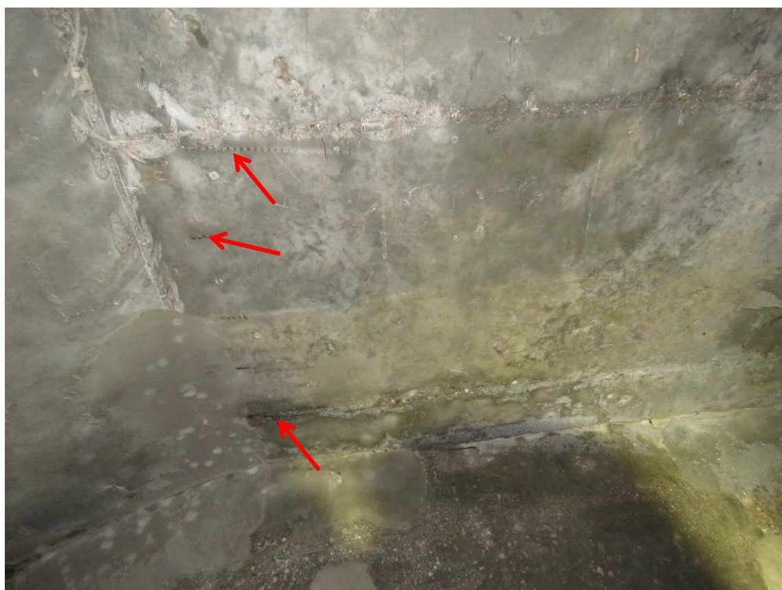
Рис. 3.5.7. Уточнение величин защитного слоя бетона монолитных лестничных конструкций
