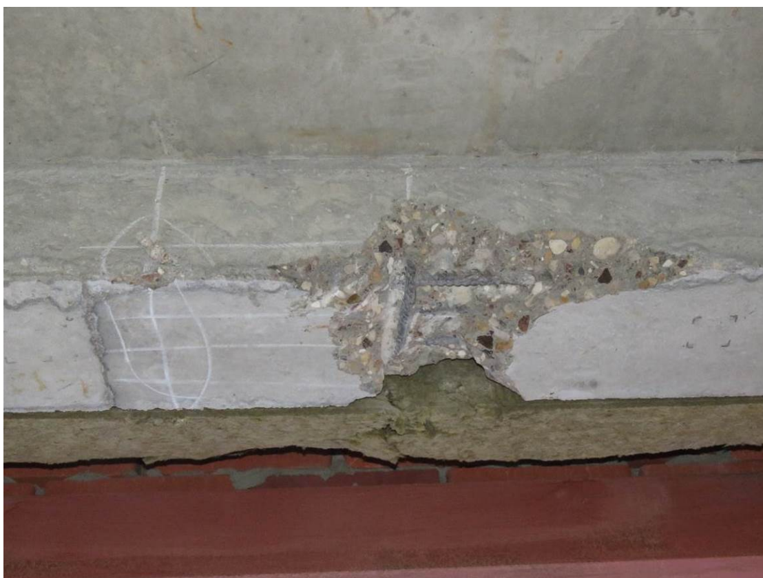
Рис. 3.3.6. Общий вид участка вскрытия монолитной ж.б. балки плиты перекрытия третьего этажа по оси 2/4 между осями Б/4-В/4
