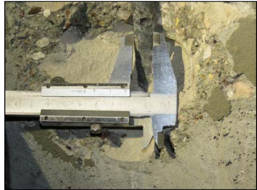
ФОТО 30. Уточнение диаметра рабочей арматуры монолитного ж/б пилона 3-го этажа расположенного по оси «6/4» между осями «Б/4»-«В/4».
