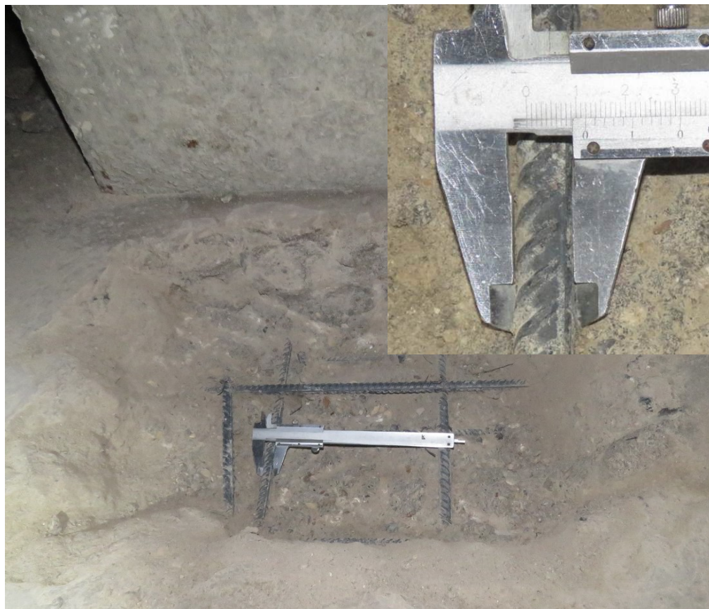
Рис. 3.1.8. Определение диаметра (12 мм) арматуры вдоль буквенных осей верхней зоны армирования фундаментной плиты на участке вскрытия по оси б/4 между осями Б/4-В/4 секции 4
