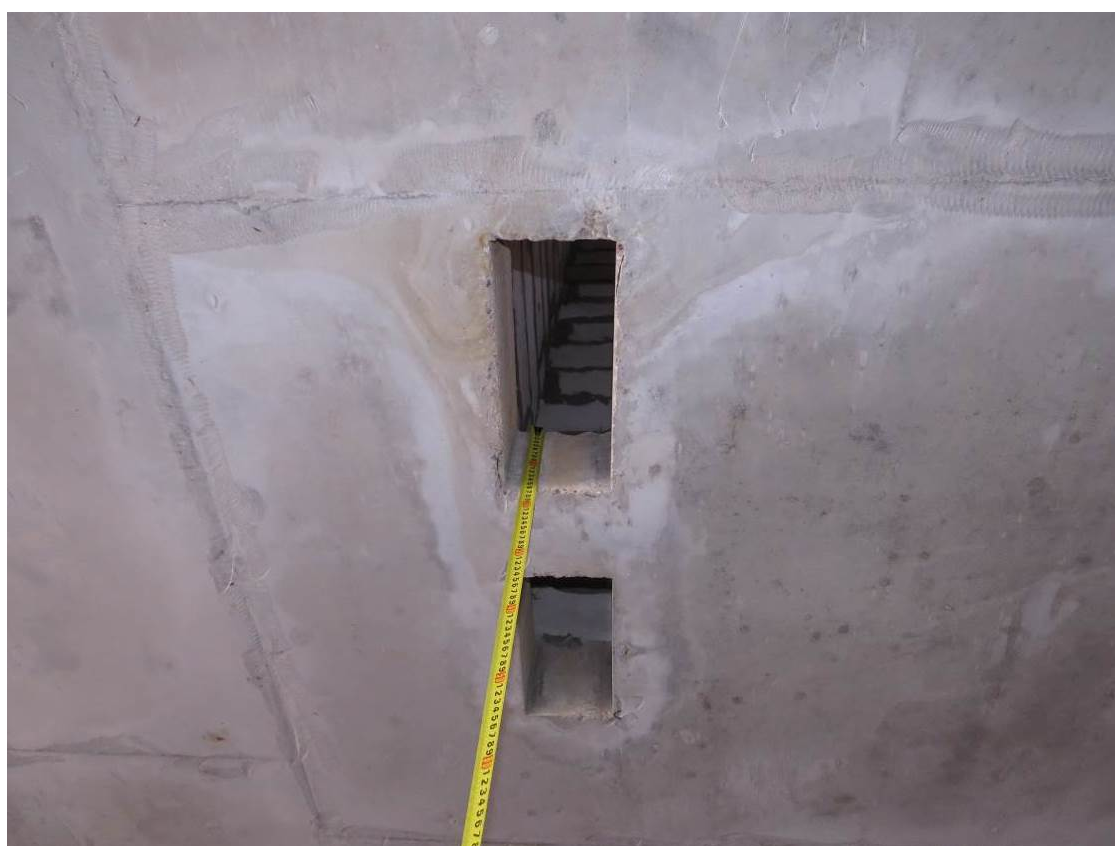
Рис. 2.2. Замер толщины плиты перекрытия первого этажа секции №1 при помощи металлической рулетки
