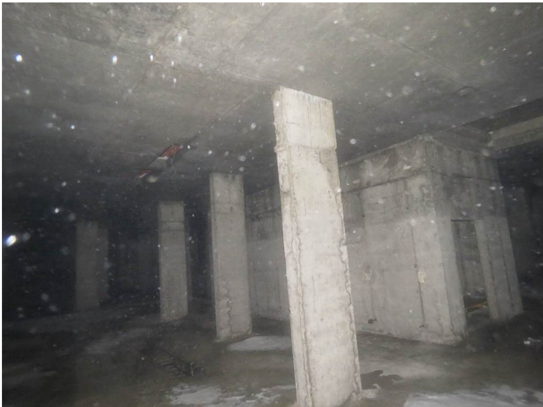
Рис. 3.3.2. Общий вид монолитной ж.б. плиты покрытия 6-го этажа
