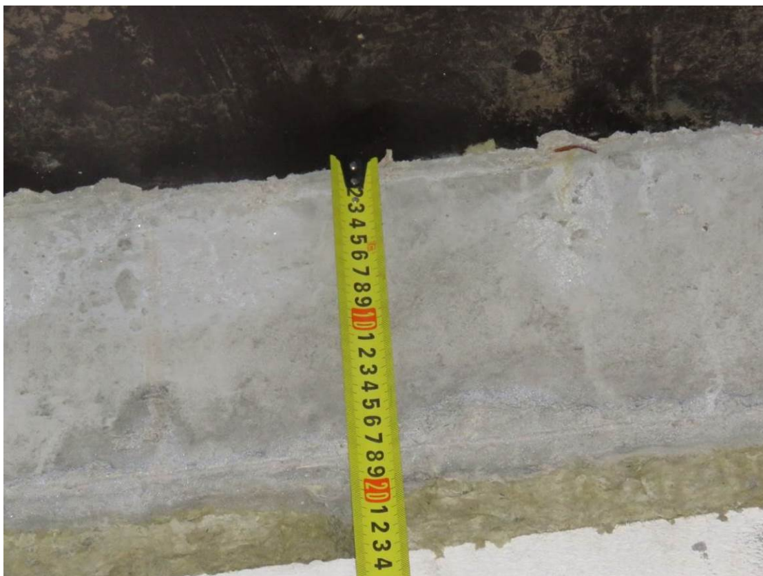
Рис. 3.3.3. Замер толщины монолитной ж.б. плиты перекрытия
