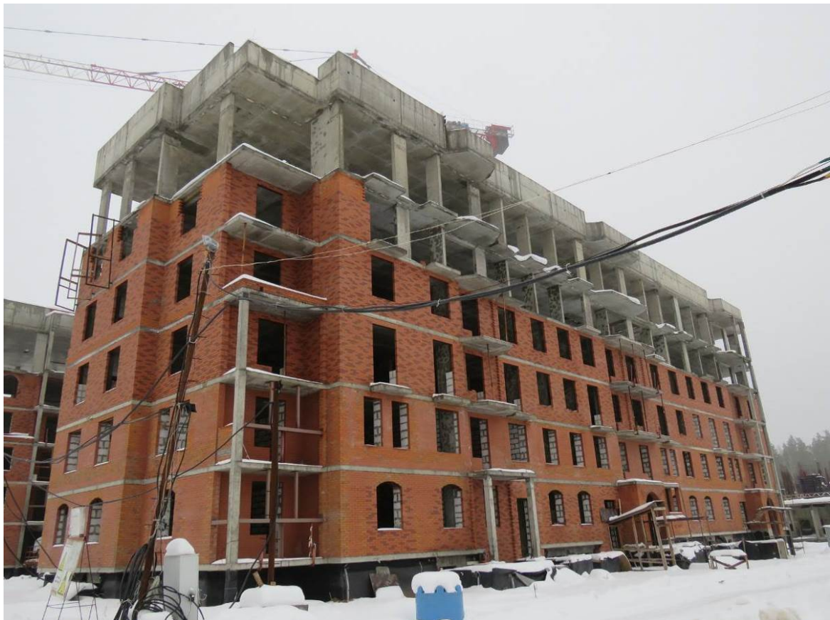
Рис. 1.1. Фасад Д-Б жилого дома №15 (секции №№5 и 6)
