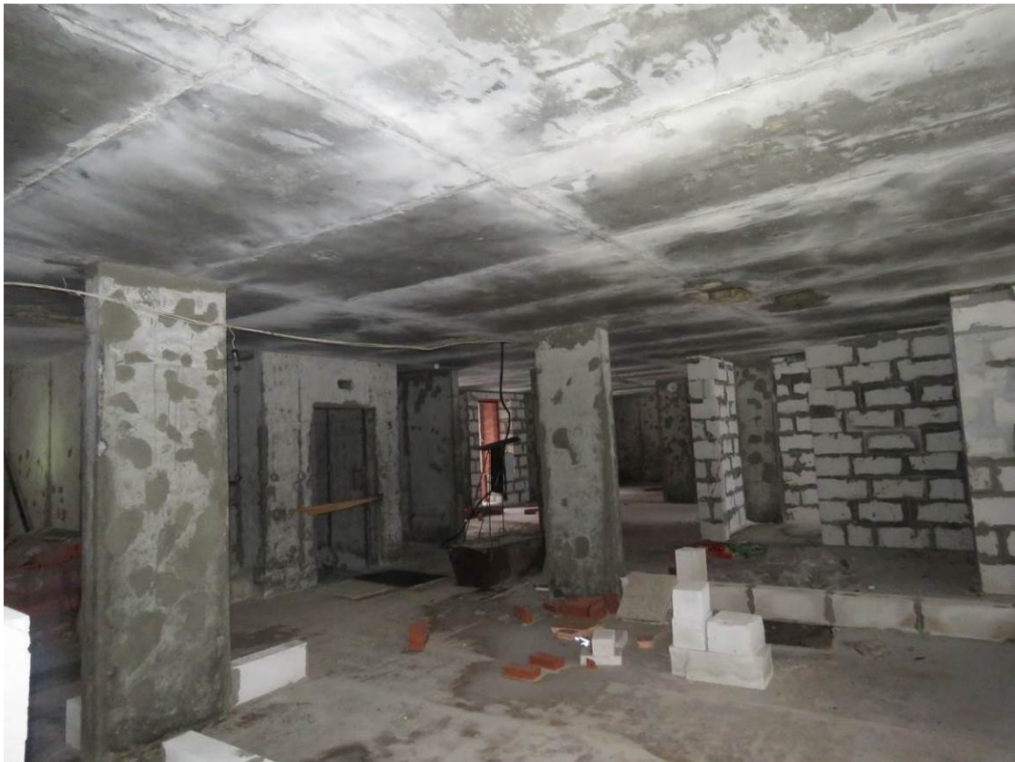
Рис. 3.3.1. Общий вид монолитной ж.б. плиты перекрытия 3-го этажа
