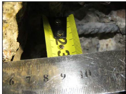
ФОТО 32. Уточнение защитного слоя бетона потолочной поверхности монолитной железобетонной плиты перекрытия 3-го этажа расположенной по оси «Б/4» между осями «6/4» и 7/4.
