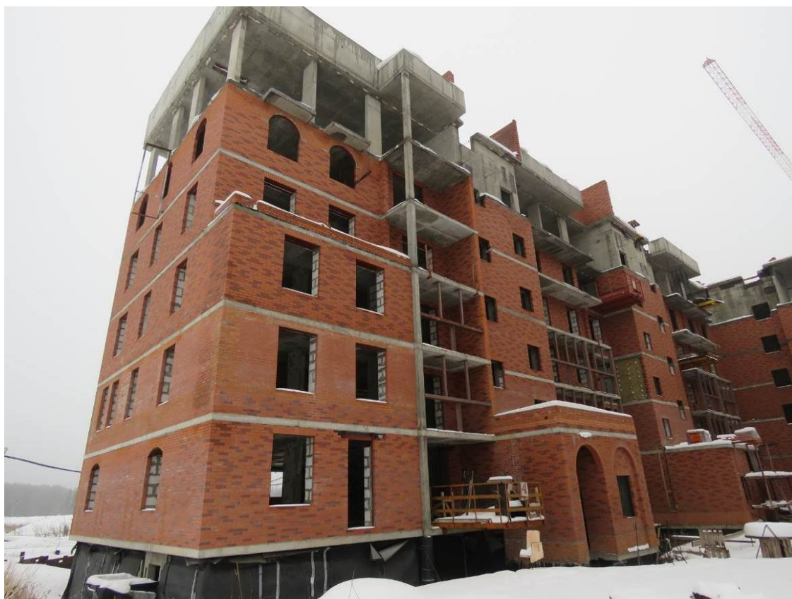
Рис. 1.4. Фасад Д-Б жилого дома №15 (секции №№1 и 2)
