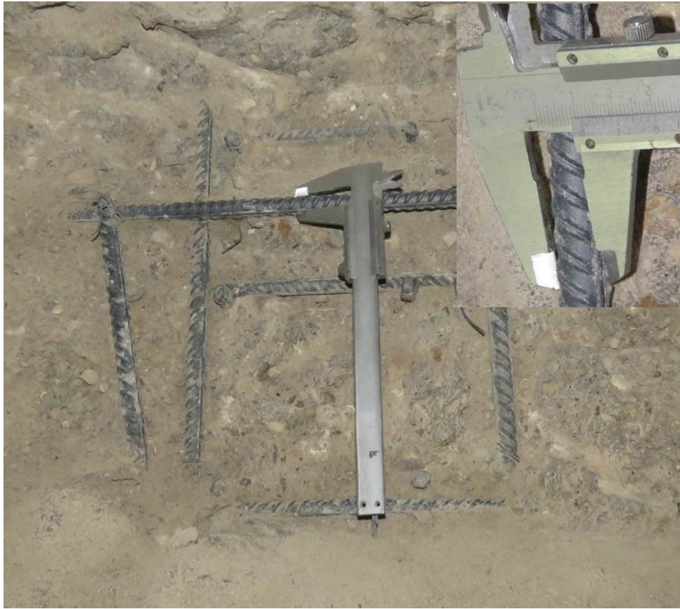
Рис. 3.1.9. Определение диаметра (12 мм) арматуры вдоль цифровых осей верхней зоны армирования фундаментной плиты на участке вскрытия по оси 6/4 между осями Б/4-В/4 секции 4
