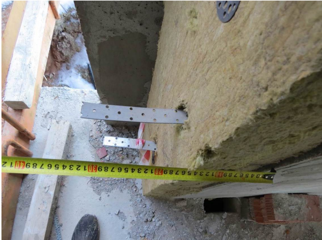
Рис. 3.4.3. Замер толщины утеплителя наружной стены жилого дома в уровне 1-го этажа (тип 2)
