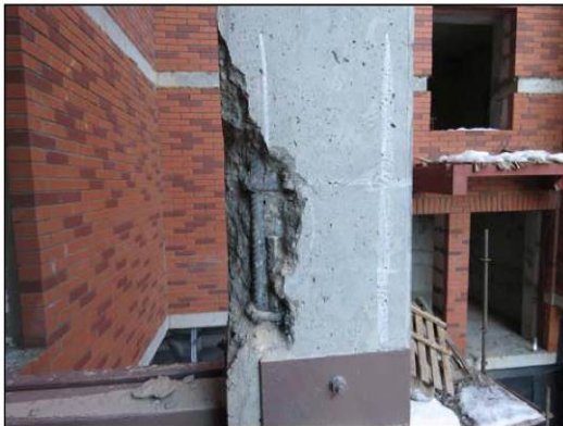
ФОТО 19. Общий вид вскрытия монолитной железобетонной колонны расположенной по оси «5/3» между осями «И/3» и «Ж/3».
