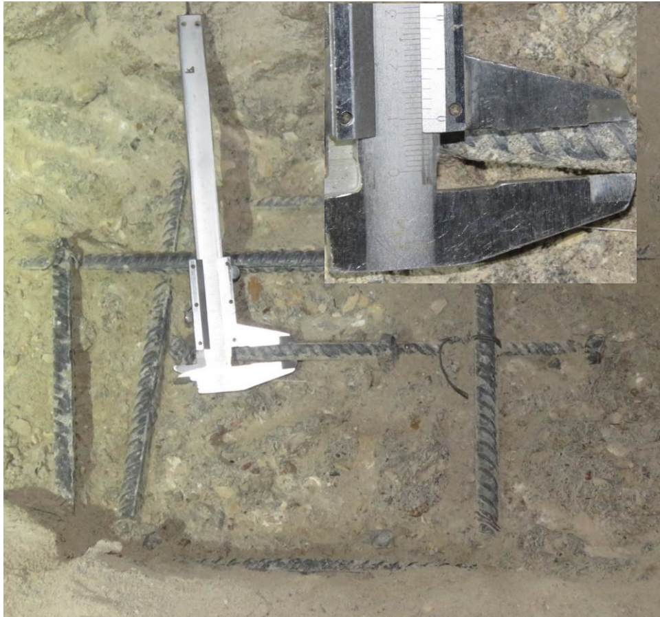
Рис. 3.1.11. Определение диаметра (10 мм) продольной арматуры поперечного армирования фундаментной плиты на участке вскрытия по оси 6/4 между осями Б/4-В/4 секции 4
