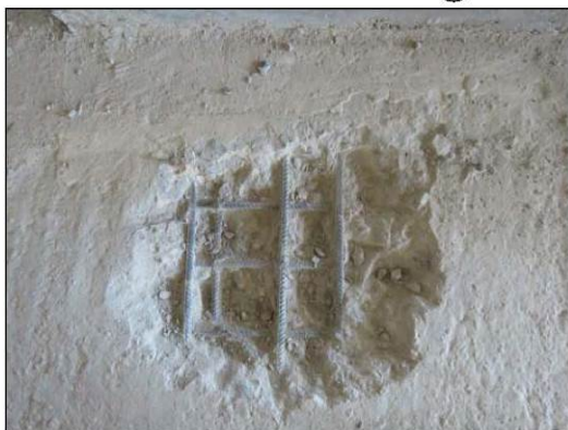
ФОТО 13. Общий вид вскрытия напольной поверхности железобетонной плиты перекрытия подвала на пересечении осей «Е/3» и «8/3».
