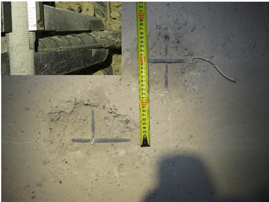
Рис. 3.3.8. Замер геометрических параметров верхнего армирования плиты перекрытия 2-го этажа между осями Г/4-Д/4 и 2/4-3/4
