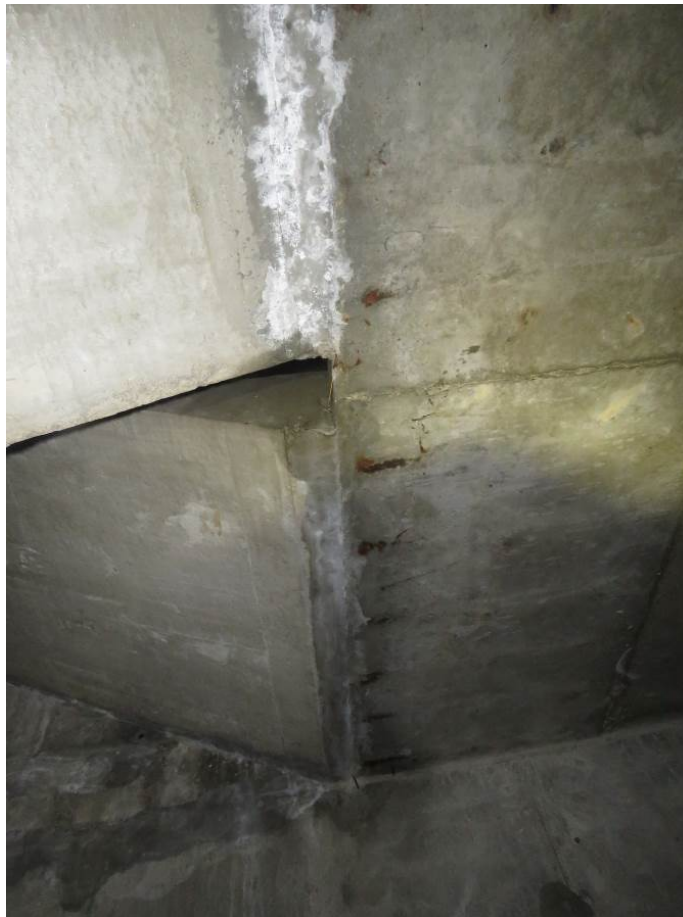
Рис. 3.5.8. (а, б) Наличие коррозии арматурного каркаса площадок лестниц с отсутствие защитного слоя бетона в том числе в зоне секции №6, в уровне 2-го этажа между осями Д/6-В/6 и 4/6-7/6
