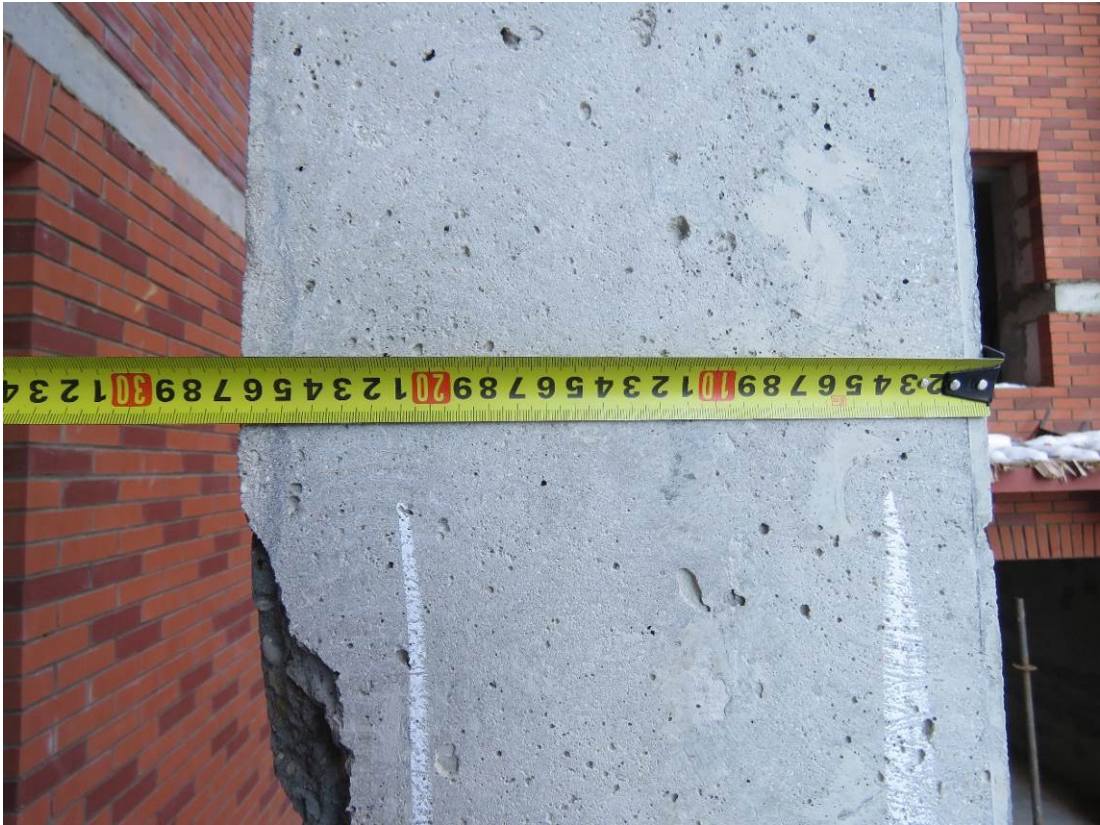
Рис. 3.2.1. Замер сечения монолитной ж.б. колонны на отм. ±0,000 м между осями Ж/3-И, 4/3-5/3
