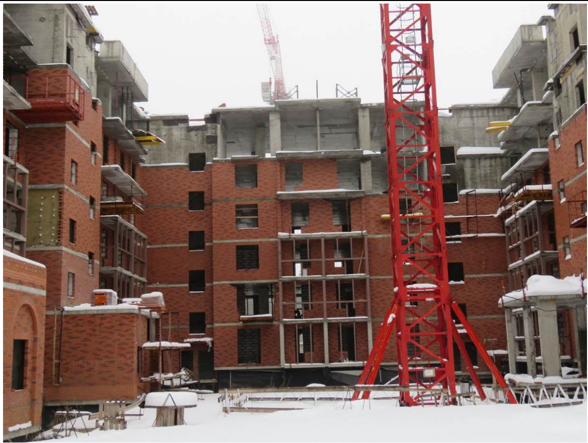
Рис. 1.5. Фасад 10-2 жилого дома №15 (секции №№3-4)
