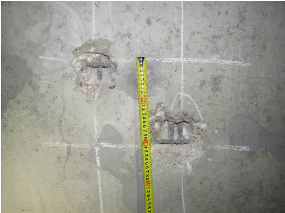
Рис. 3.2.2. Замер шага горизонтального армирования стены на отм. -3,300 м по оси 1/4 между осями В/4-Г/4
