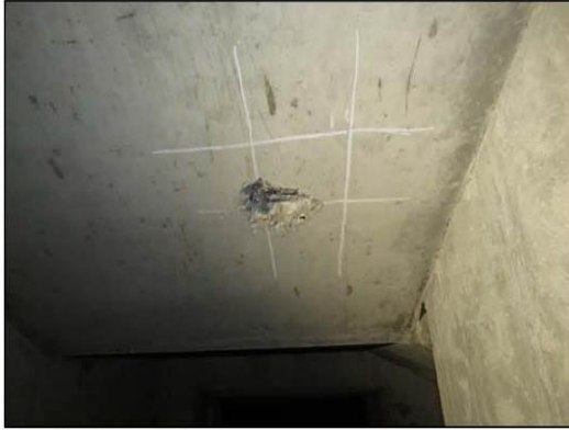
ФОТО 33. Общий вид вскрытия монолитного ж/б лестничного марша между 3-м и 4-м этажом между осей «4/5»-«5/5» и «Д/5»-«Е/5».
