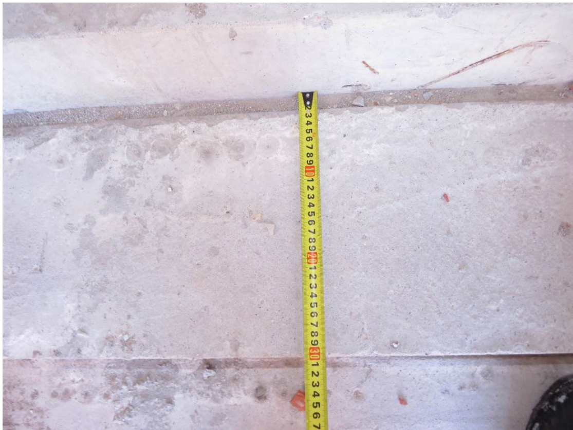
Рис. 3.5.6. Уточнение габарита проступи монолитной лестничной одномаршевой конструкции
