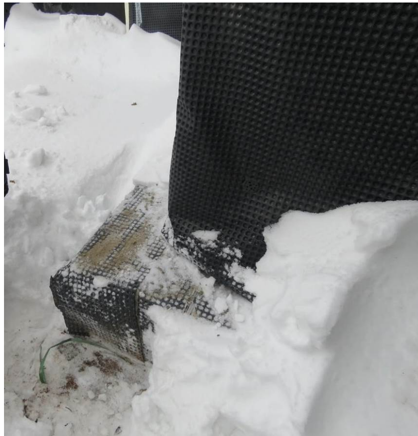
Рис. 3.1.1. Шурф №1, секция 1 на пересечении осей 6/2 и Л/1
