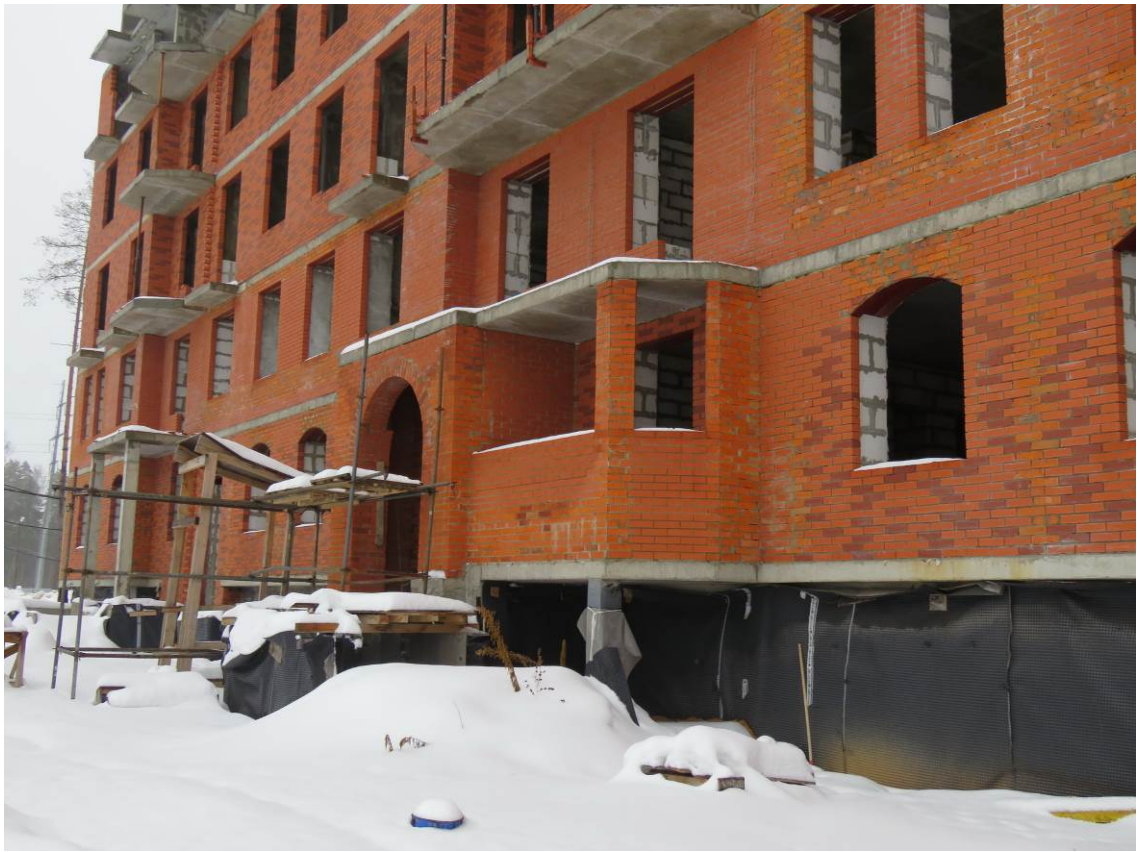
Рис. 3.4.1. Общий вид ограждающих конструкций наружных стен жилого дома №15
