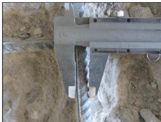
ФОТО 14. Уточнение диаметра рабочей арматуры напольной поверхности железобетонной плиты перекрытия подвала на пересечении осей «Е/3» и «8/3».
