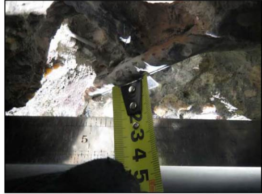
ФОТО 34. Уточнение диаметра рабочей арматуры монолитного ж/б лестничного марша между 3-м и 4-м этажом между осей «4/5»-«5/5» и «Д/5»-«Е/5».
