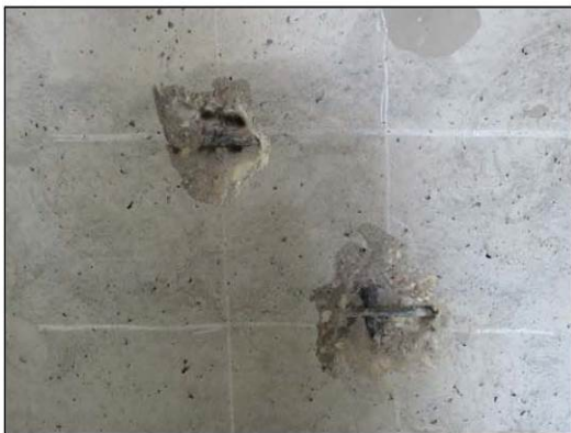
ФОТО 11. Общий вид вскрытия монолитной ж/б стены 1-го этажа расположенной по оси «Г/3» между осями «4/3»-«5/3».
