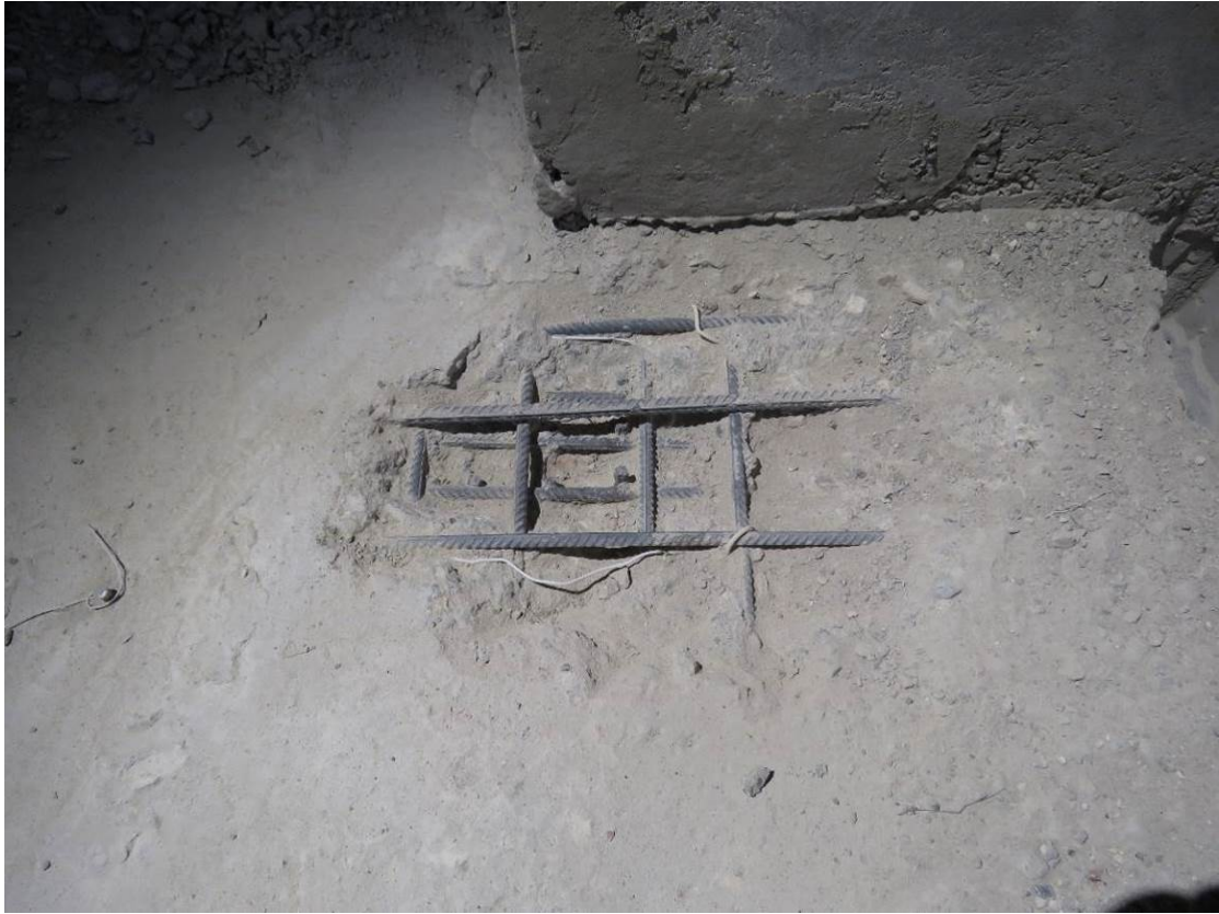
Рис. 3.3.9. Общий вид участка вскрытия монолитной ж.б. плиты перекрытия 2-го этажа в зоне пилона на пересечении осей А/4 и 4/4
